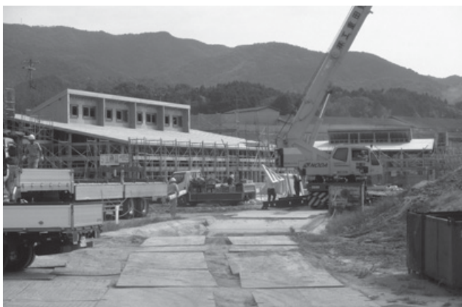
(建設中の「ふれあいどころ437」)
