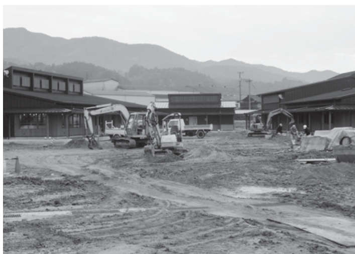
(4月12日オープンに向けて建設中の“ふれあいどころ437” )
